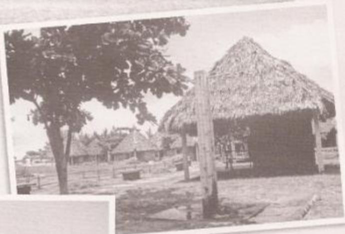
Fotografía 38. Turiscentro San Carlos (Panamá).
